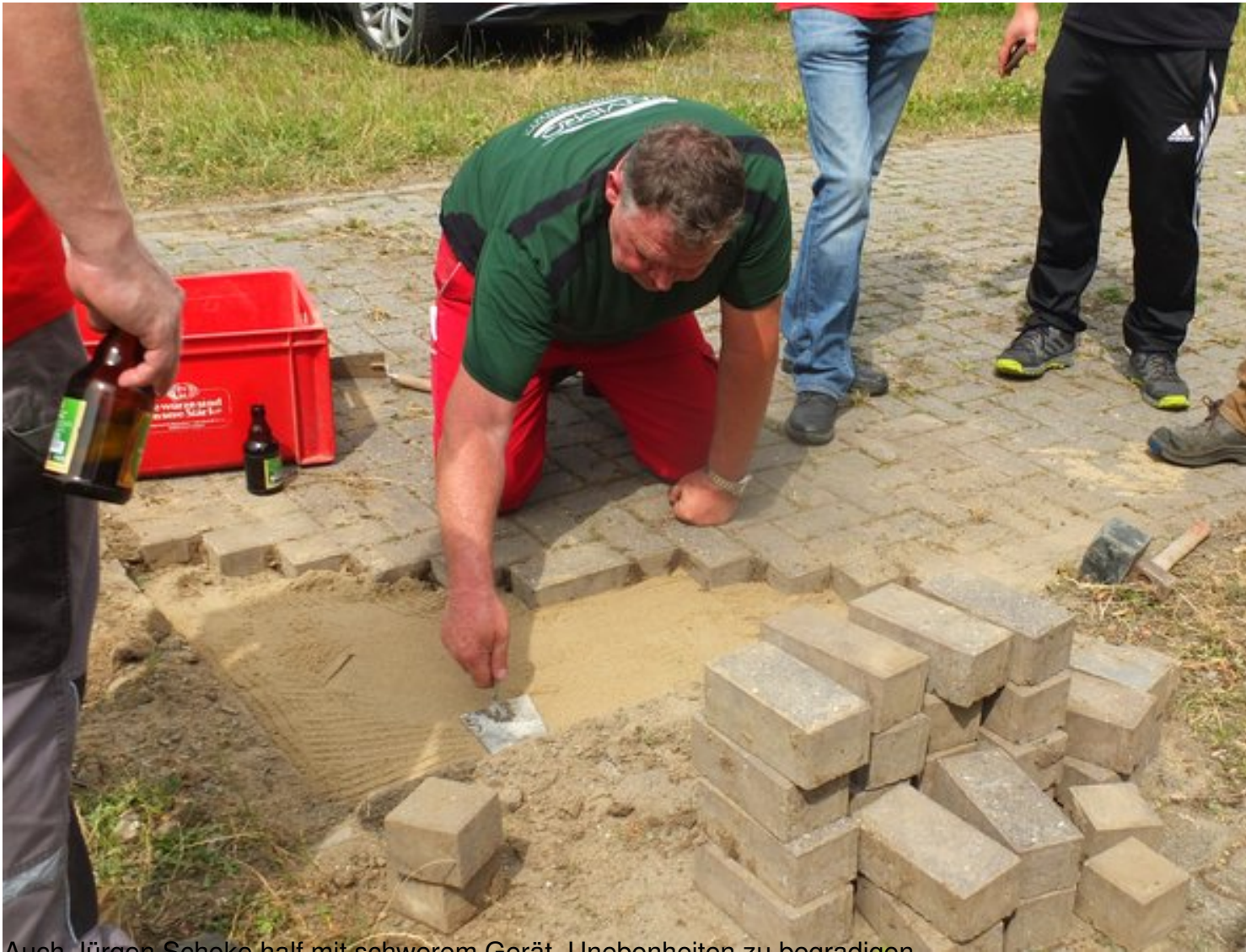
Auch Jürgen Schoke half mit schwerem Gerät, Unebenheiten zu begradigen.
